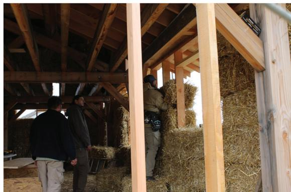
Une ossature- bois pour le remplissage avec les bottes de paille est posée à l'extérieur du «poteau-poutre»
